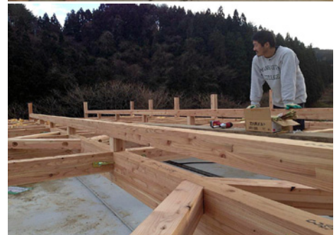
ピースジャムのスタッフをはじめ、全国から手伝いに来たボランティアや地元の若者によって建設中の工房。たくさんの思いが詰まった建物が、今月末に完成します
